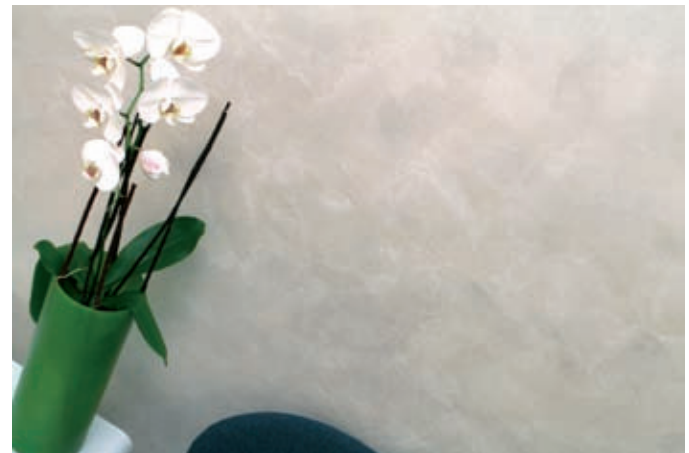
Im Wartebereich hinter dem Empfang sind die Wände in der ArteTwin-Technik gestaltet, das ist eine Spachteltechnik, bei der hier ArteTwin Basic mit dem Farbton Ginster zusammen auf einer Kelle in Fleckspachtelung auf die Wand aufgetragen wurden.
